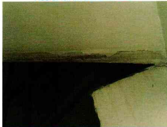
FIGURA 16. PINTURA DANIFICADA.
