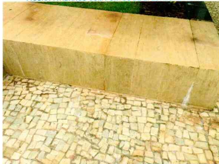
FIGURA 147. BANCO COM PONTOS DE EFLORESCÊNCIA.
