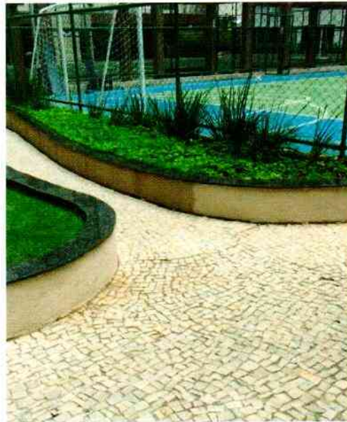
FIGURA 79.AUSÊNCIA DE REJUNTE NO GRANITO E TRINCAS NAS MURETAS DE JARDIM.
