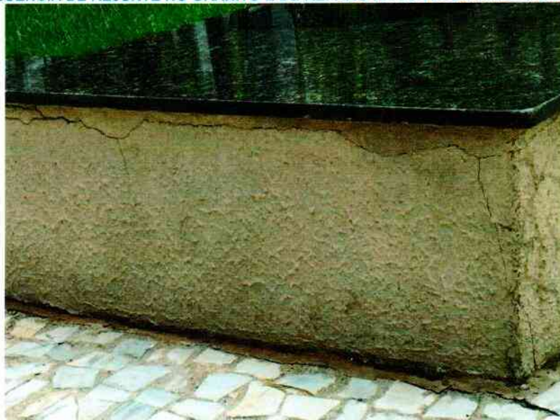
FIGURA 113. AUSÊNCIA DE REJUNTE NO GRANITO E DE REPARO NA JUNTA DA BASE MURETA DE JARDIM.
