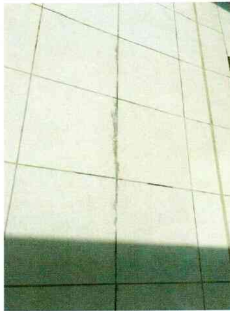
FIGURA 50.AUSÊNCIA DE REJUNTE.
