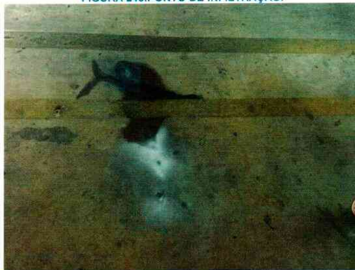
FIGURA 243.PONTO DE INFILTRAÇÃO.
