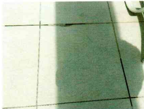
FIGURA 46.CERÂMICA SEM REJUNTE.
