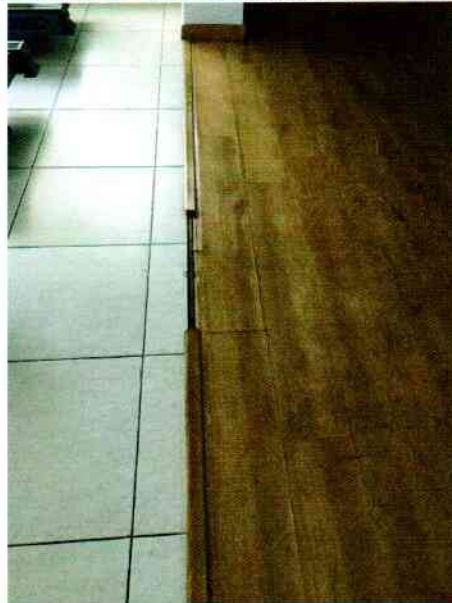
FIGURA 74. PISO COM ACABAMENTO DANIFICADO.
