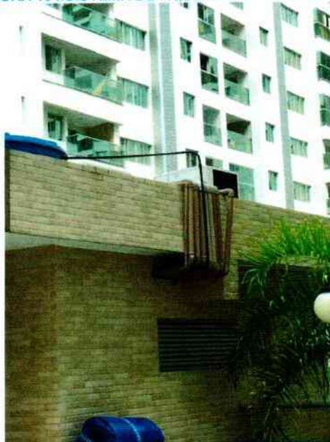
FIGURA 134.SISTEMA DE AQUECIMENTO DA PISCINA.
