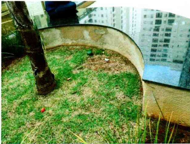
FIGURA 111. AUSÊNCIA DE REJUNTE NO GRANITO E DE REPARO NA JUNTA DA BASE MURETA DE JARDIM.
