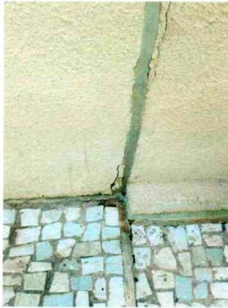
FIGURA 220. TRINCAS EM JUNTA DE DILATAÇÃO.
