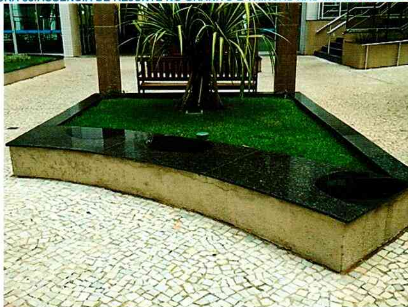
FIGURA 85. AUSÊNCIA DE REJUNTE NO GRANITO E TRINCAS NAS MURETAS DE JARDIM.
