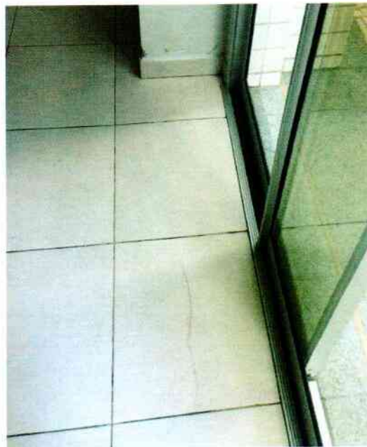
FIGURA 230.AUSÊNCIA DE REJUNTE.
