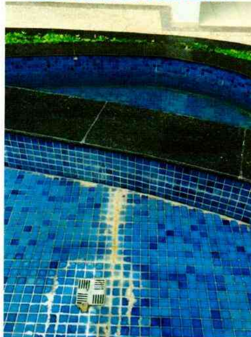
FIGURA 123.PASTILHAS SEM REJUNTE.
