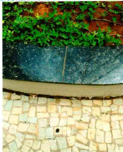
FIGURA 79.AUSÊNCIA DE REJUNTE NO GRANITO E TRINCAS NAS MURETAS DE JARDIM.
