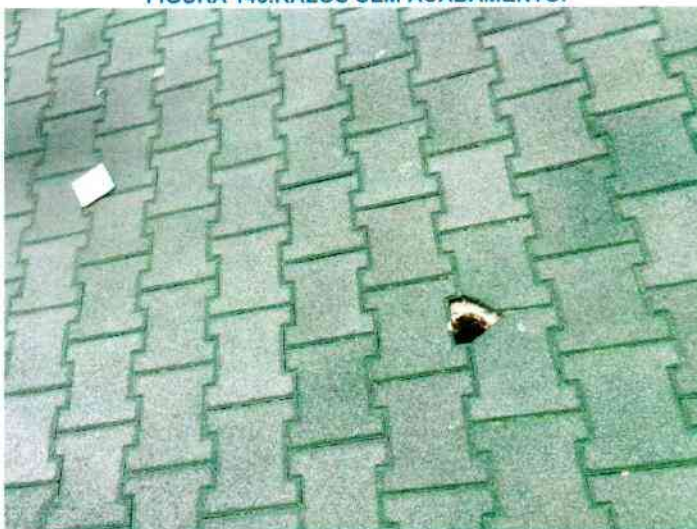
FIGURA 145.RALOS SEM ACABAMENTO.
