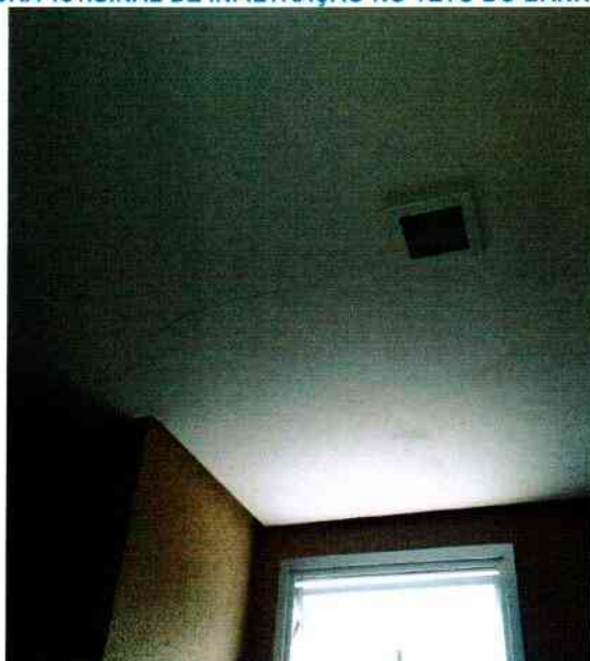
FIGURA 151.SINAL DE INFILTRAÇÃO NO TETO DO BANHEIRO.
