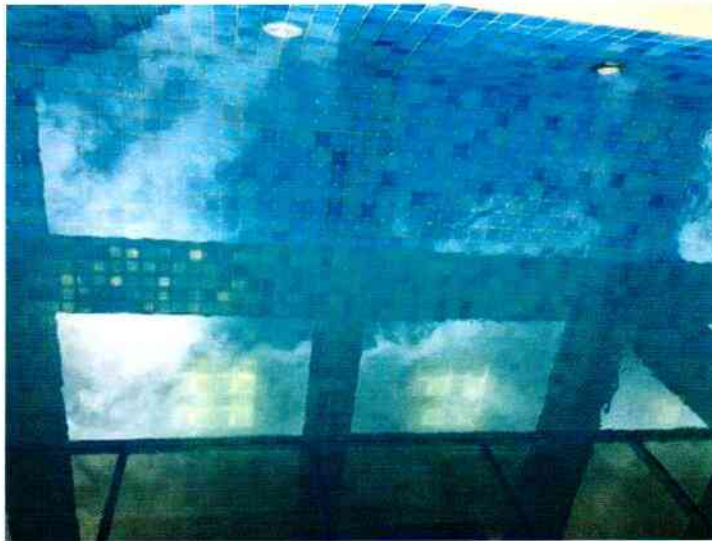
FIGURA 52.AUSÊNCIA DE REJUNTE.
