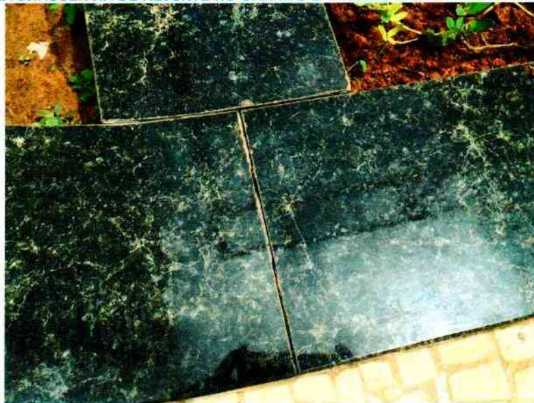
FIGURA 89. AUSÊNCIA DE REJUNTE NO GRANITO E TRINCAS NAS MURETAS DE JARDIM.
