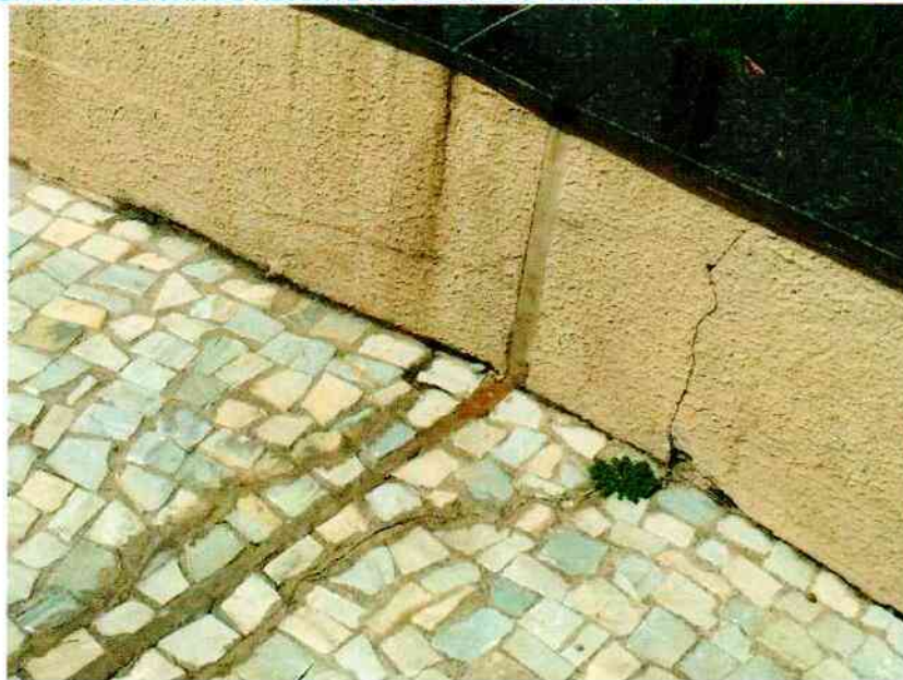
FIGURA 93. AUSÊNCIA DE REJUNTE NO GRANITO E TRINCAS NAS MURETAS DE JARDIM.
