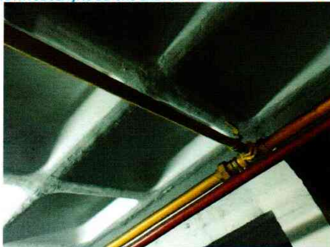
FIGURA 246. TUBULAÇÃO DE GÁS EXECUTADA POSTERIORMENTE A ENTRADA.
