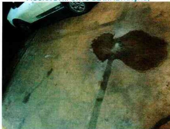
FIGURA 241.PONTO DE INFILTRAÇÃO.
