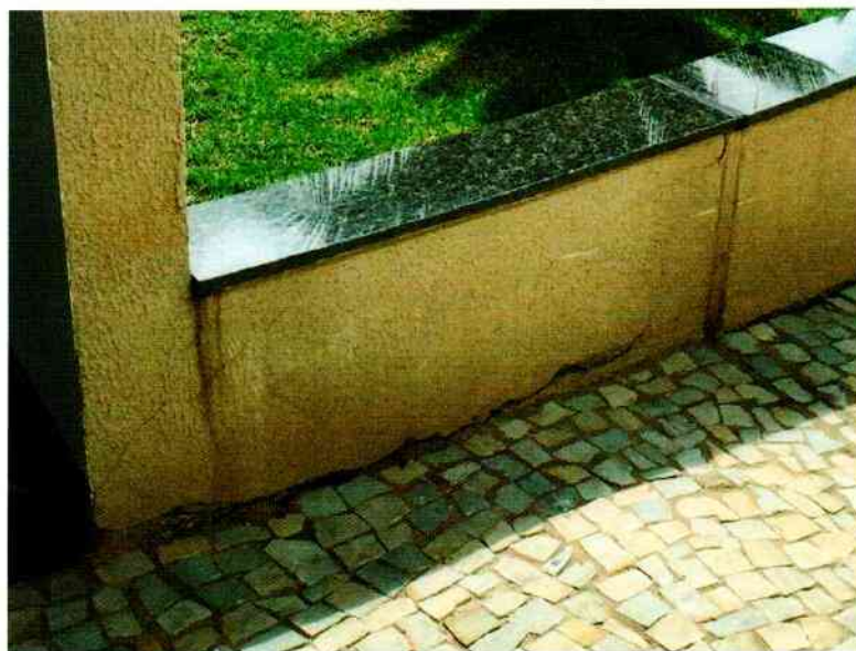
FIGURA 96. AUSÊNCIA DE REJUNTE NO GRANITO E DE REPARO NA JUNTA DA BASE MURETA DE JARDIM.
