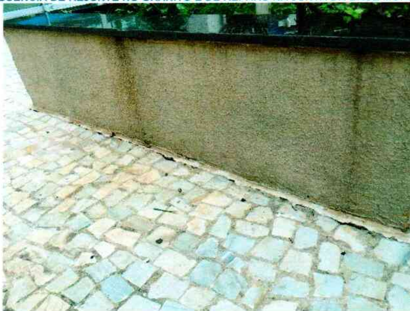
FIGURA 111. AUSÊNCIA DE REJUNTE NO GRANITO E DE REPARO NA JUNTA DA BASE MURETA DE JARDIM.
