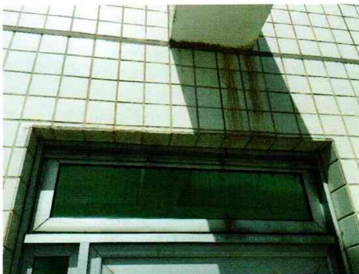
FIGURA 70. JUNTAS DE PAGINAÇÃO RESSECADAS.
