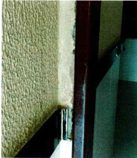
FIGURA 166.PINTURA DANIFICADA.
