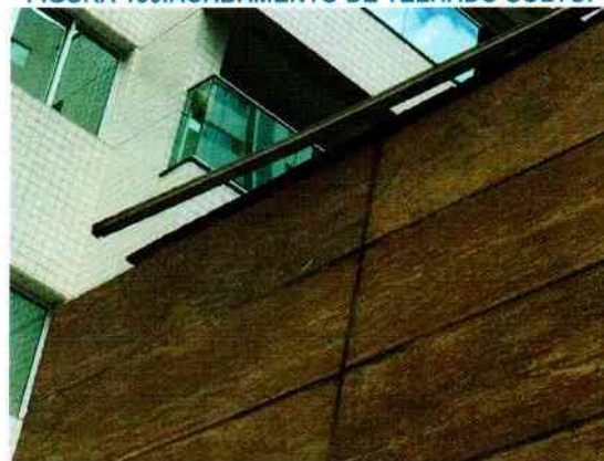
FIGURA 130.ACABAMENTO DE TELHADO SOLTO.
