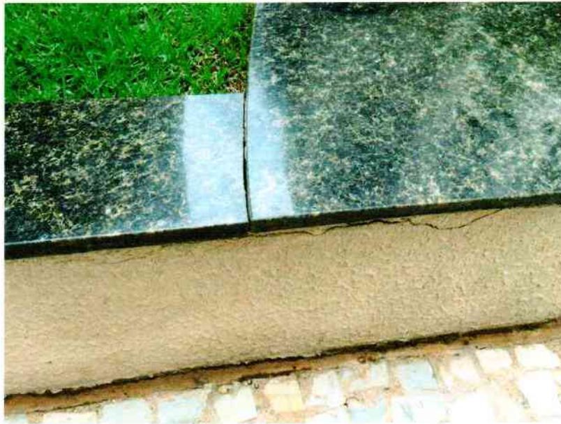
FIGURA 113. AUSÊNCIA DE REJUNTE NO GRANITO E DE REPARO NA JUNTA DA BASE MURETA DE JARDIM.
