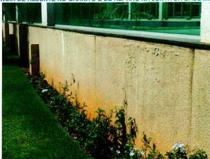
FIGURA 98. AUSÊNCIA DE REJUNTE NO GRANITO E DE REPARO NA JUNTA DA BASE MURETA DE JARDIM.
