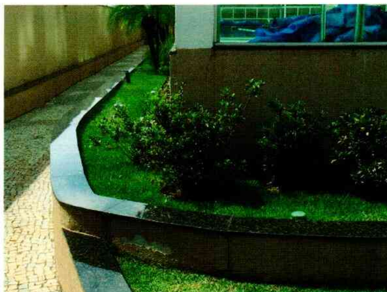
FIGURA 98. AUSÊNCIA DE REJUNTE NO GRANITO E DE REPARO NA JUNTA DA BASE MURETA DE JARDIM.
