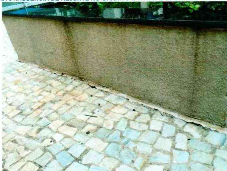
FIGURA 91. AUSÊNCIA DE REJUNTE NO GRANITO E TRINCAS NAS MURETAS DE JARDIM.
