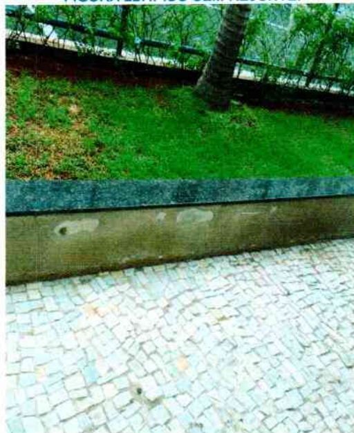
FIGURA 227. PISO SEM REJUNTE.
