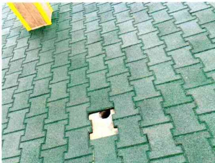
FIGURA 145.RALOS SEM ACABAMENTO.
