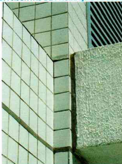
FIGURA 70. JUNTAS DE PAGINAÇÃO RESSECADAS.
