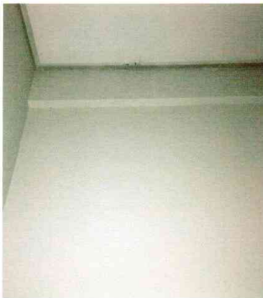
FIGURA 151.SINAL DE INFILTRAÇÃO NO TETO DO BANHEIRO.
