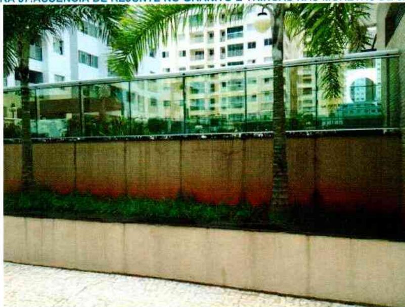
FIGURA 87. AUSÊNCIA DE REJUNTE NO GRANITO E TRINCAS NAS MURETAS DE JARDIM.
