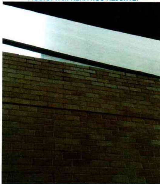
FIGURA 170.FALHA NOS REJUNTE.
