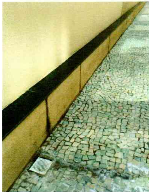
FIGURA 107. AUSÊNCIA DE REJUNTE NO GRANITO E DE REPARO NA JUNTA DA BASE MURETA DE JARDIM.
