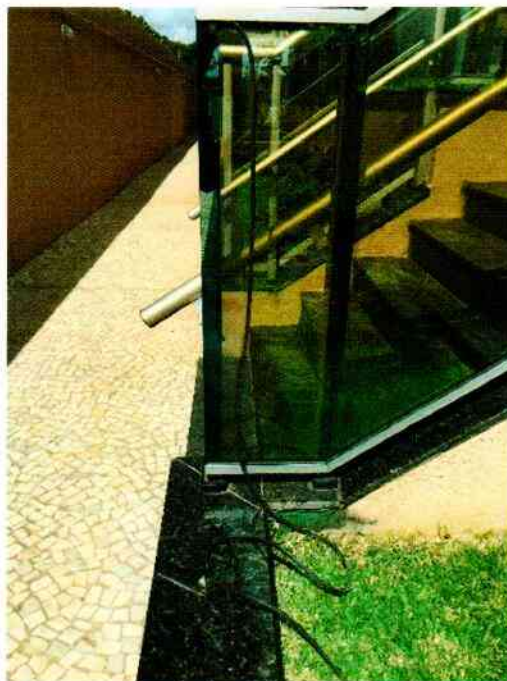
FIGURA 215. BORRACHA DE FIXAÇÃO DE VIDROS SOLTA.
