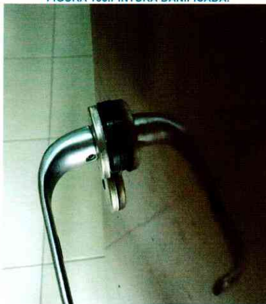
FIGURA 166.PINTURA DANIFICADA.
