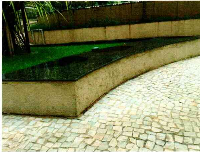
FIGURA 89. AUSÊNCIA DE REJUNTE NO GRANITO E TRINCAS NAS MURETAS DE JARDIM.
