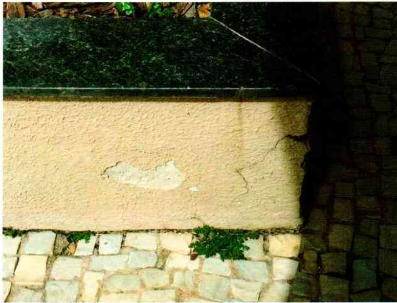
FIGURA 93. AUSÊNCIA DE REJUNTE NO GRANITO E TRINCAS NAS MURETAS DE JARDIM.
