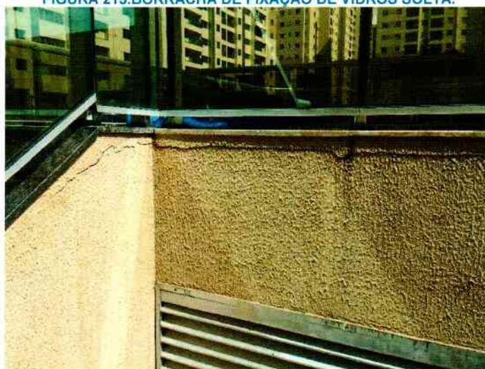
FIGURA 215. BORRACHA DE FIXAÇÃO DE VIDROS SOLTA.
