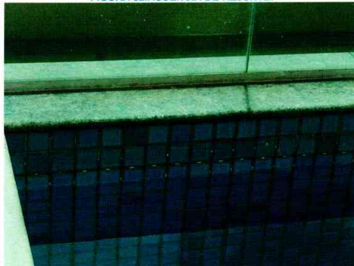
FIGURA 52.AUSÊNCIA DE REJUNTE.
