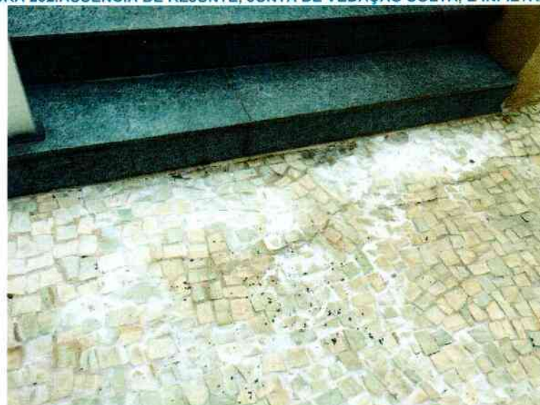
FIGURA 202. AUSÊNCIA DE REJUNTE, JUNTA DE VEDAÇÃO SOLTA, E INFILTRAÇÃO.
