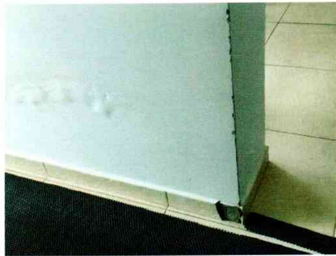
FIGURA 60. INFILTRAÇÃO EM PAREDE.
