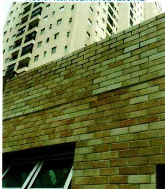
FIGURA 168.AUSÊNCIA DE REJUNTE.
