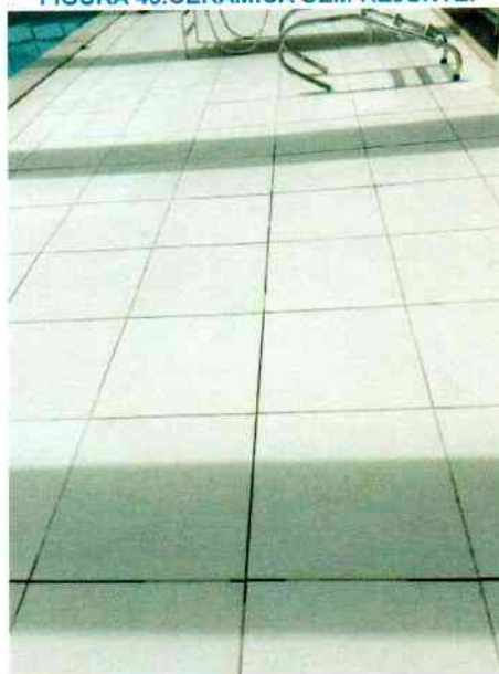
FIGURA 48.CERÂMICA SEM REJUNTE.
