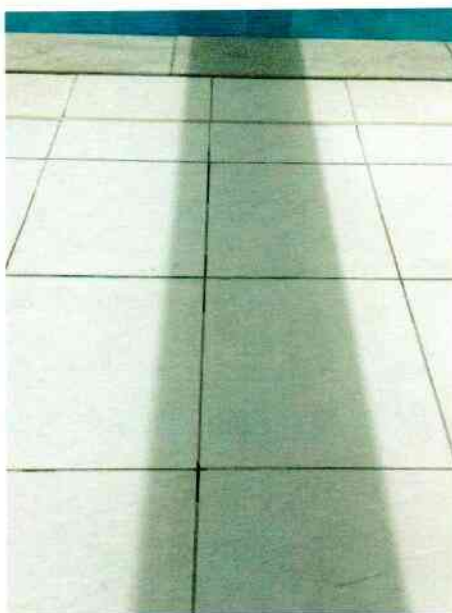
FIGURA 48.CERÂMICA SEM REJUNTE.
