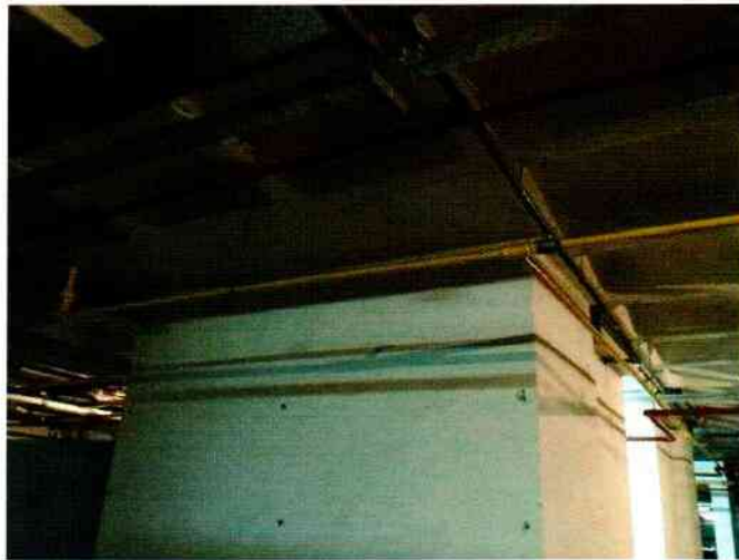
FIGURA 246. TUBULAÇÃO DE GÁS EXECUTADA POSTERIORMENTE A ENTRADA.
