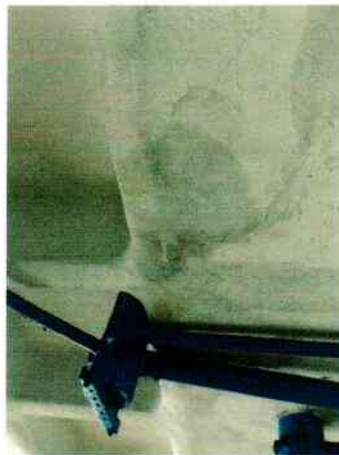
FIGURA 241.PONTO DE INFILTRAÇÃO.
