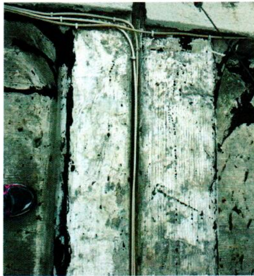
FIGURA 270.DANOS NA MANTA DE IMPERMEABILIZAÇÃO.
