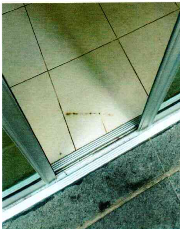
FIGURA 229.PISO QUEBRADO.
