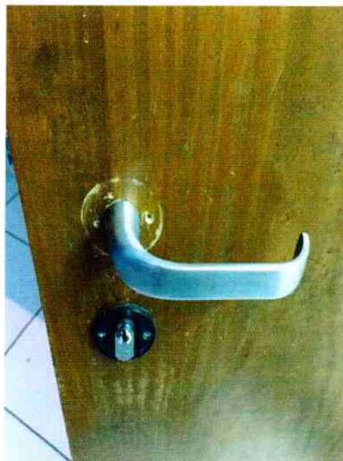
FIGURA 177.MAÇANETA QUEBRADA.
