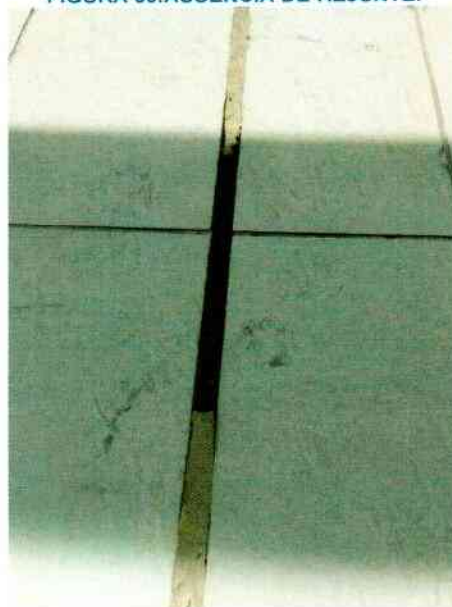
FIGURA 50.AUSÊNCIA DE REJUNTE.
