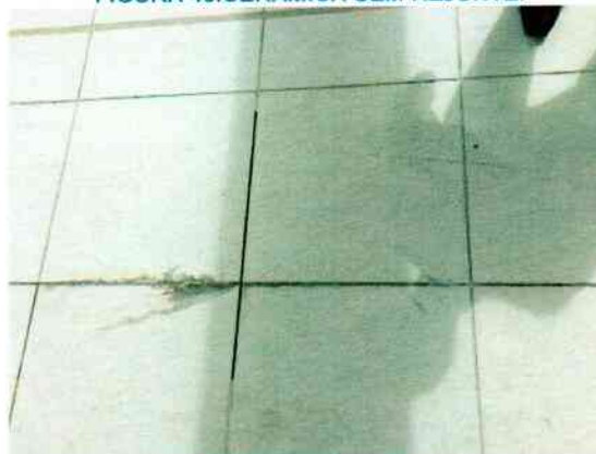
FIGURA 46.CERÂMICA SEM REJUNTE.
