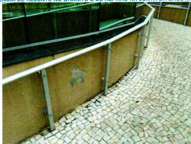
FIGURA 109. AUSÊNCIA DE REJUNTE NO GRANITO E DE REPARO NA JUNTA DA BASE MURETA DE JARDIM.
