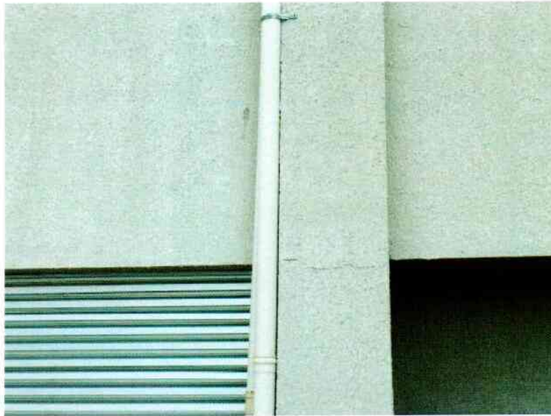
FIGURA 9. TRINCAS NA PAREDE DA FACHADA.
