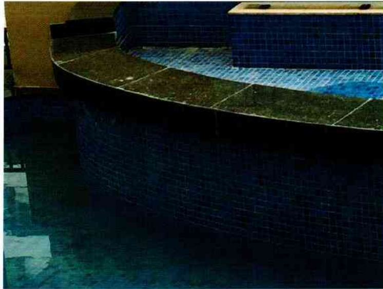
FIGURA 127. AUSÊNCIA DE REJUNTE NO GRANITO .
