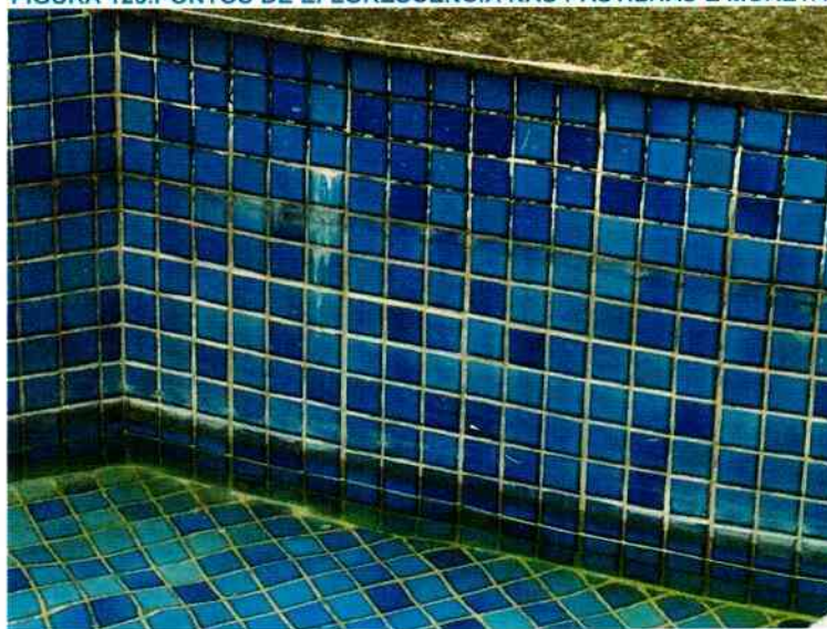
FIGURA 125. PONTOS DE EFLORESCÊNCIA NAS PASTILHAS E MURETA.
