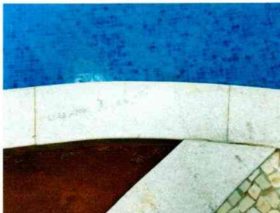
FIGURA 35. BORDAS DA PISCINA SEM REJUNTE ENTRE AS PEDRAS.
