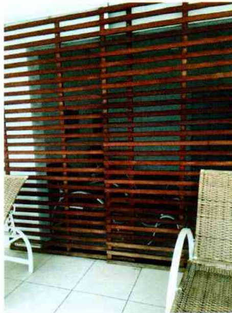
FIGURA 66. AUSÊNCIA DE VERNIZ EM MADEIRA.
