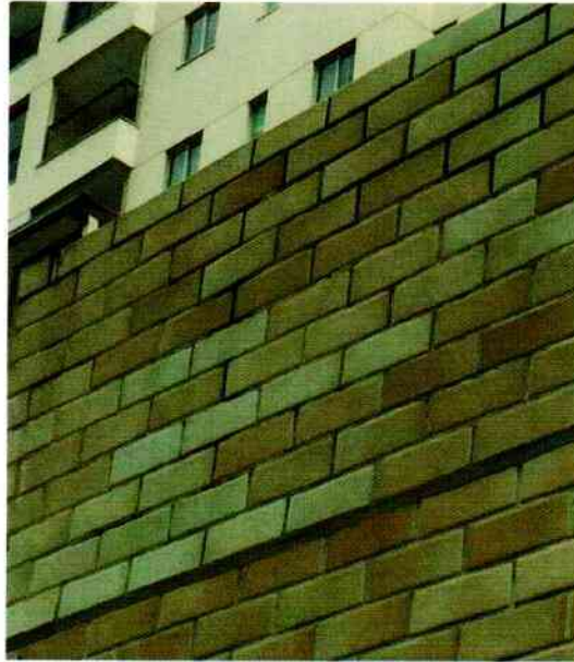
FIGURA 170.FALHA NOS REJUNTE.
