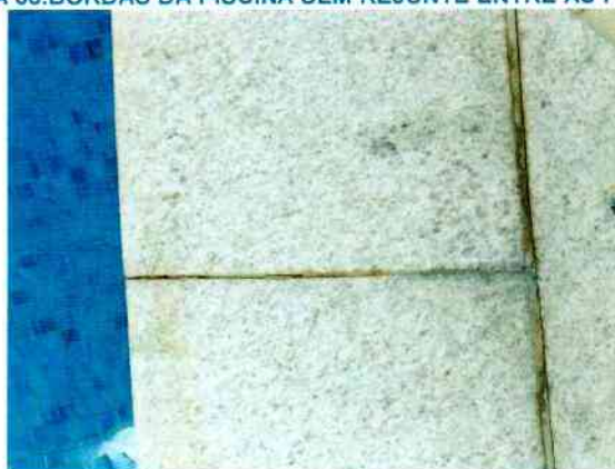
FIGURA 35. BORDAS DA PISCINA SEM REJUNTE ENTRE AS PEDRAS.
