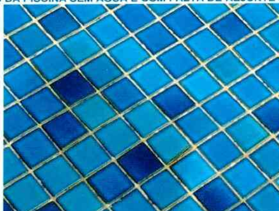
FIGURA 27. LAVA-PÉS DA PISCINA SEM ÁGUA E COM FALTA DE REJUNTE ENTRE AS PASTILHAS.
