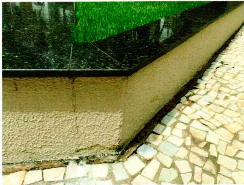
FIGURA 85. AUSÊNCIA DE REJUNTE NO GRANITO E TRINCAS NAS MURETAS DE JARDIM.
