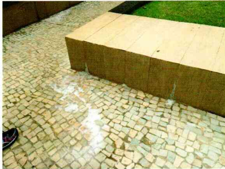
FIGURA 147. BANCO COM PONTOS DE EFLORESCÊNCIA.
