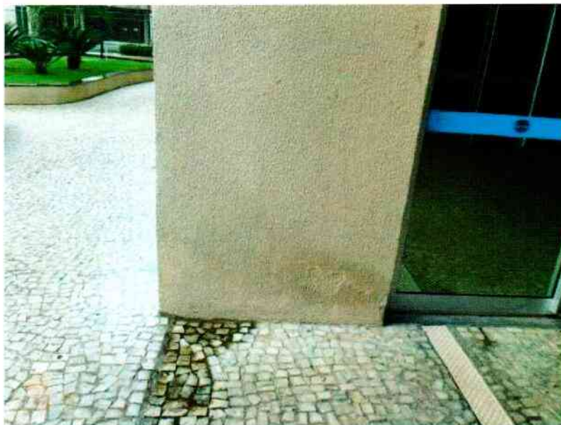
FIGURA 119. PONTOS DE INFILTRAÇÃO E PINTURA DESCASCANDO.
