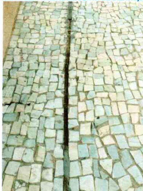
FIGURA 220. TRINCAS EM JUNTA DE DILATAÇÃO.
