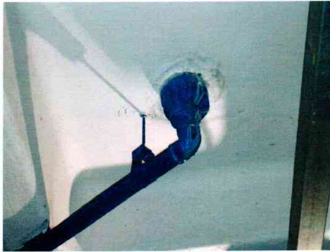
FIGURA 243.PONTO DE INFILTRAÇÃO.
