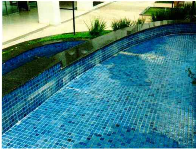
FIGURA 123.PASTILHAS SEM REJUNTE.
