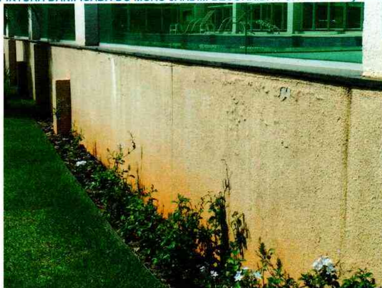
FIGURA 105. PINTURA DANIFICADA DO MURO JARDIM DECORRIDA POR INFILTRAÇÃO JÁ REPARADA.
