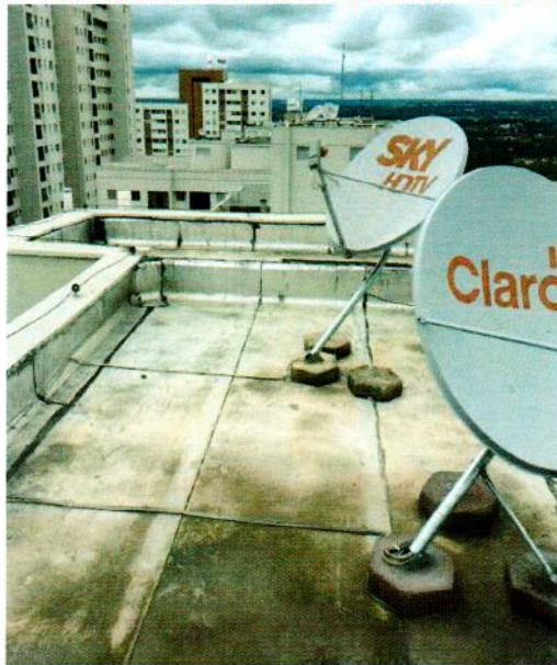
FIGURA 270.DANOS NA MANTA DE IMPERMEABILIZAÇÃO.
