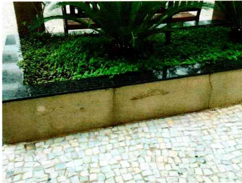
FIGURA 91. AUSÊNCIA DE REJUNTE NO GRANITO E TRINCAS NAS MURETAS DE JARDIM.
