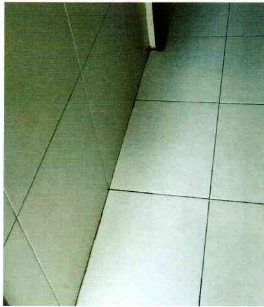
FIGURA 168.AUSÊNCIA DE REJUNTE.
