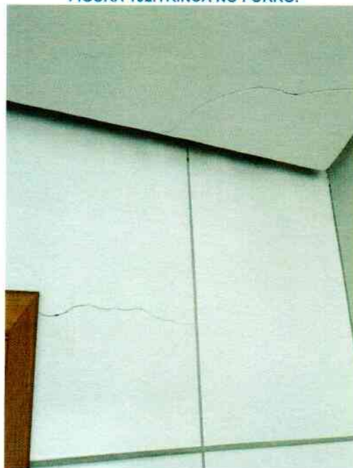
FIGURA 192. TRINCA NO FORRO.
