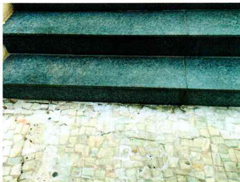
FIGURA 202. AUSÊNCIA DE REJUNTE, JUNTA DE VEDAÇÃO SOLTA, E INFILTRAÇÃO.
