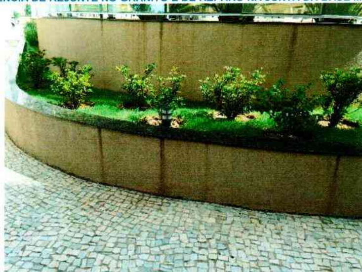
FIGURA 107. AUSÊNCIA DE REJUNTE NO GRANITO E DE REPARO NA JUNTA DA BASE MURETA DE JARDIM.
