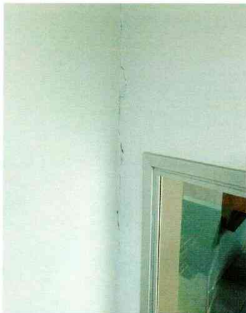
FIGURA 175.FISSURA NA PAREDE.
