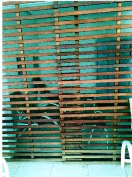
FIGURA 66. AUSÊNCIA DE VERNIZ EM MADEIRA.
