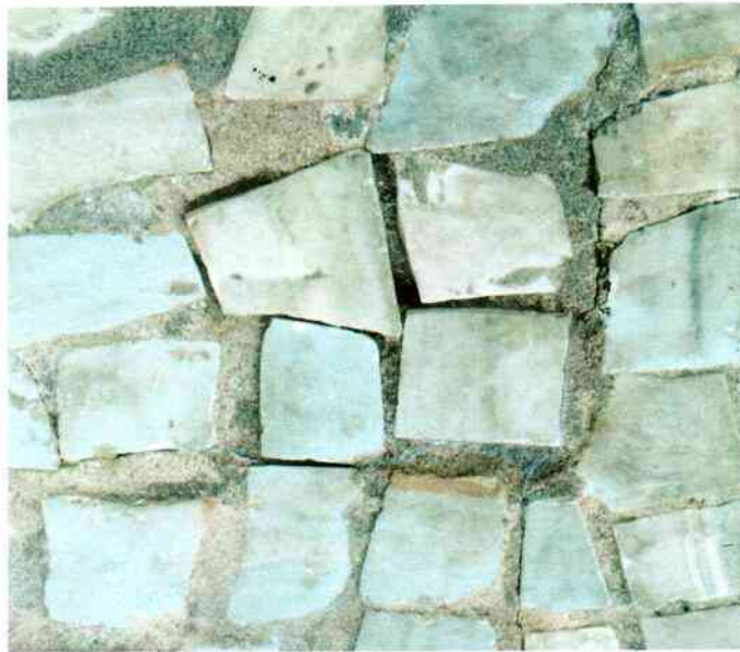
FIGURA 227. PISO SEM REJUNTE.
