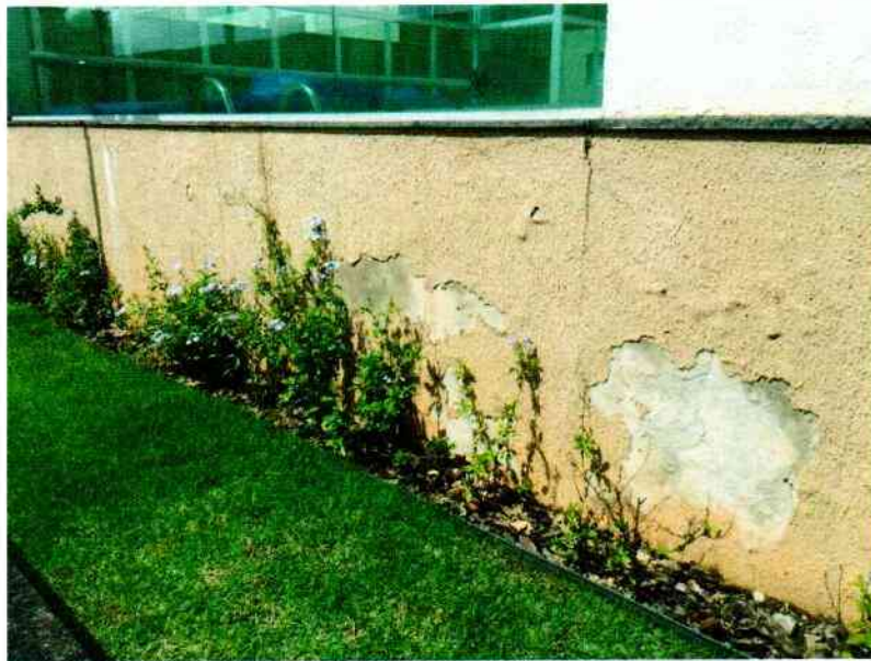
FIGURA 105. PINTURA DANIFICADA DO MURO JARDIM DECORRIDA POR INFILTRAÇÃO JÁ REPARADA.
